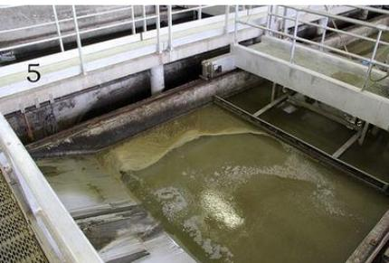
Das Abwasser kommt jetzt zum wichtigsten Schritt an: Es erreicht einen Behälter mit Bakterien. Die Bakterien fressen die Verschmutzung und verwandeln sie in Schlamm. Das Wasser wird in den Fluss (den Rhein) wiedergestürzt und der Schlamm wird verbrannt.
