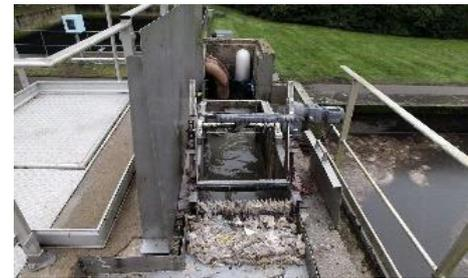
Dann kommt das Abwasser in einen Behälter, um Sand und Öl zu entfernen. Der Sand wird flüssig und das Öl kommt an die Oberfläche. Wir müssen dann beide Schichten abschaben: der Sand wird recycelt und das Öl wird verbrannt.
