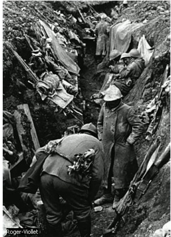
L'enfer des tranchées.
