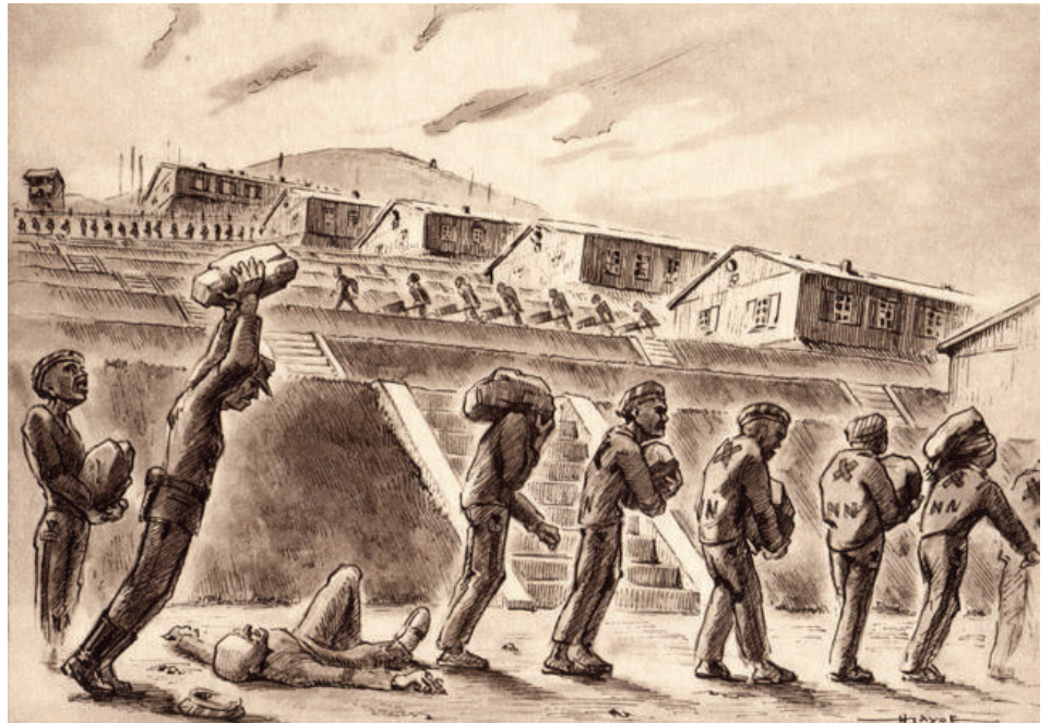
Travaux de terrassement - gravure de Henri Gayot, déporté du KL-Natzweiler © Fonds André Gayot
